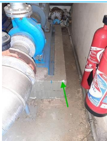
Matériaux : ZPSO-013 Prélèvement : P022 Description : Peinture de sol sur massif béton Localisation : Chauffage - Sous station Résultat : Absence d'amiante
