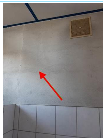
Matériaux : ZPSO-006 Prélèvement : P012 Description : Enduit à base de plâtre + peinture Localisation : Chauffage - WC Résultat : Présence d'amiante
