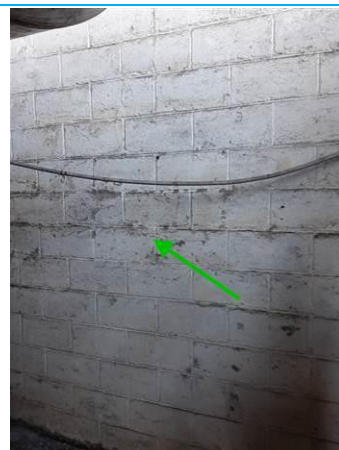
Matériaux : ZPSO-012 Prélèvement : P021 Description : Joint entre blocs de béton aggro Localisation : Chauffage - Salle des chaudières Résultat : Absence d'amiante
