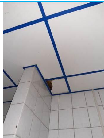
Matériaux : ZPSO-004 Prélèvement : P004 Description : Panneaux de faux plafond Localisation : Chauffage - Douches Résultat : Absence d'amiante
