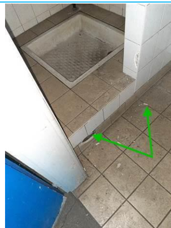
Matériaux : ZPSO-002 Prélèvement : P002 Description : Colle de plinthes Localisation : Chauffage - Douches Résultat : Absence d'amiante
