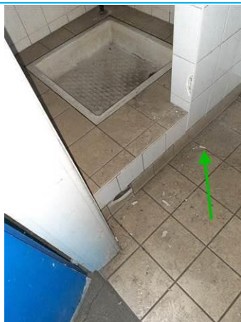
Matériaux : ZPSO-001 Prélèvement : P001 Description : Colle de carrelage Localisation : Chauffage - Douches Résultat : Absence d'amiante
