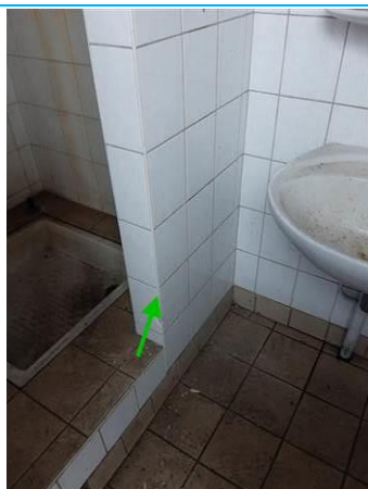
Matériaux : ZPSO-003 Prélèvement : P003 Description : Colle de faïence Localisation : Chauffage - Douches Résultat : Absence d'amiante
