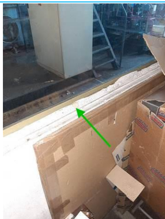
Matériaux : ZPSO-010 Prélèvement : P018 Description : Joint de mastic de vitrage Localisation : Chauffage - Local 1 Résultat : Absence d'amiante
