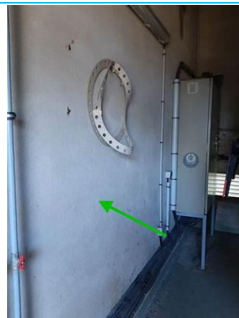
Matériaux : ZPSO-014 Prélèvement : P025 Description : Enduit à base de ciment projeté Localisation : Chaufferie - Sous station Résultat : Absence d'amiante
