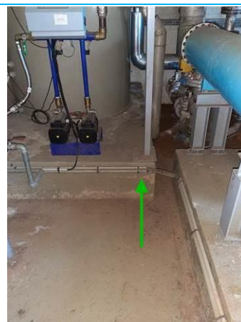
Matériaux : ZPSO-013 Prélèvement : P023 Description : Peinture de sol sur massif béton Localisation : Chauffage - Sous station Résultat : Absence d'amiante
