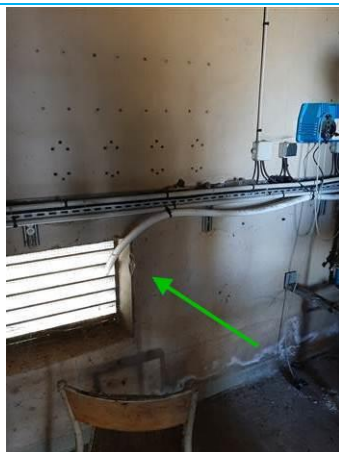
Matériaux : ZPSO-014 Prélèvement : P024 Description : Enduit à base de ciment projeté Localisation : Chaufferie - Sous station Résultat : Absence d'amiante
