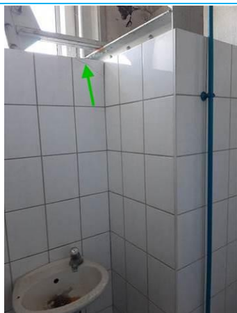
Matériaux : ZPSO-003 Prélèvement : P009 Description : Colle de faïence Localisation : Chauffage - WC Résultat : Absence d'amiante
