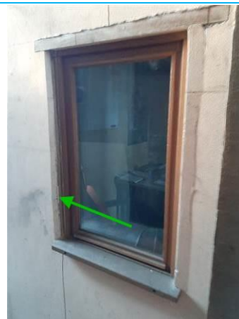
Matériaux : ZPSO-011 Prélèvement : P019 Description : Joint d'étanchéité entre menuiserie et structure Localisation : Chauffage - Local 2 Résultat : Absence d'amiante
