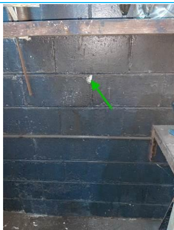
Matériaux : ZPSO-012 Prélèvement : P020 Description : Joint entre blocs de béton aggro Localisation : Chauffage - Salle des chaudières Résultat : Absence d'amiante
