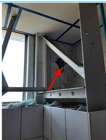
Matériaux : ZPSO-006 Prélèvement : P011 Description : Enduit à base de plâtre + peinture Localisation : Chauffage - WC Résultat : Présence d'amiante
