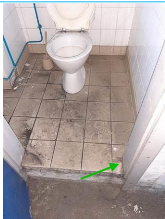
Matériaux : ZPSO-001 Prélèvement : P007 Description : Colle de carrelage Localisation : Chauffage - WC Résultat : Absence d'amiante
