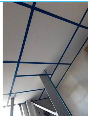
Matériaux : ZPSO-004 Prélèvement : P010 Description : Panneaux de faux plafond Localisation : Chauffage - WC Résultat : Absence d'amiante
