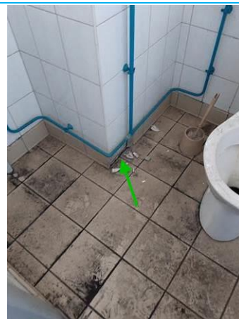
Matériaux : ZPSO-002 Prélèvement : P008 Description : Colle de plinthes Localisation : Chauffage - WC Résultat : Absence d'amiante
